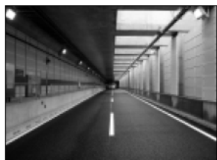
図-3 半地下式トンネル
