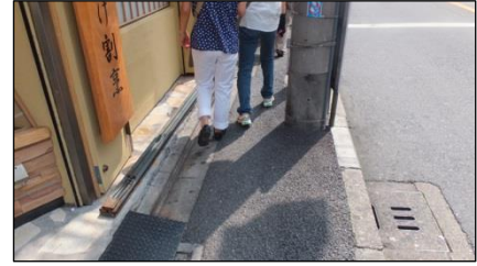
【幅員の狭い歩道】
