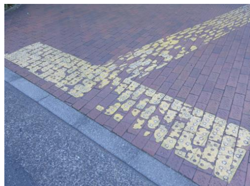
誘導用ブロックの摩耗、劣化
