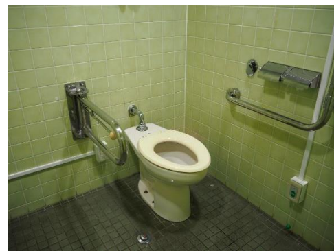
施設内の古いトイレ
