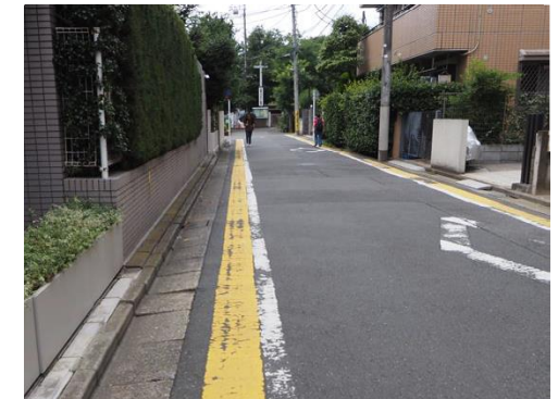
路側帯のカラー舗装が劣化している
