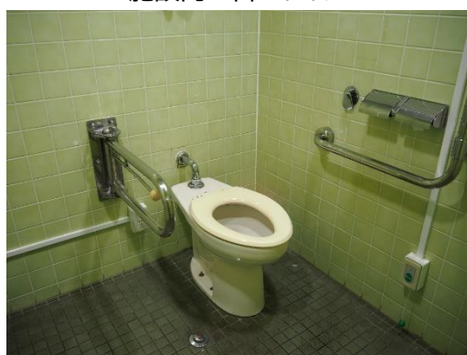
施設内の古いトイレ
