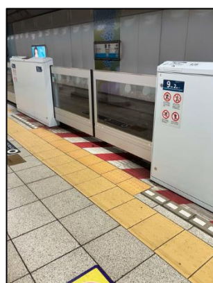
視覚障害者誘導用ブロック（落合駅）
