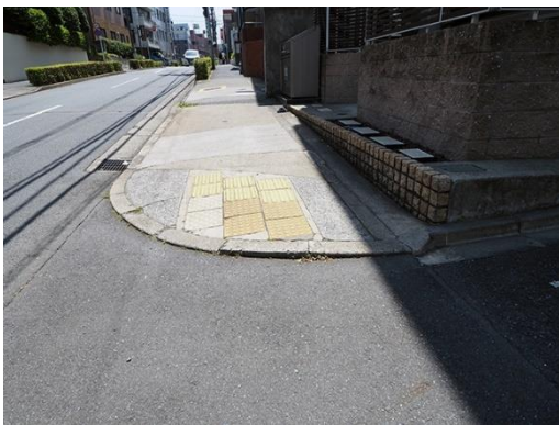
歩道と車道の境の段差を改善してほしい
