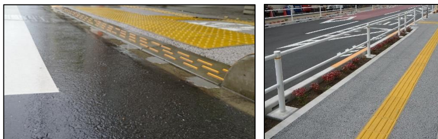
歩道の段差改善や視覚障害者誘導用ブロックの整備（新井天神通り）
