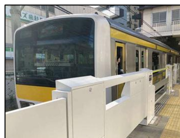
ホームドア*が整備されたプラットフォーム（東中野駅）
