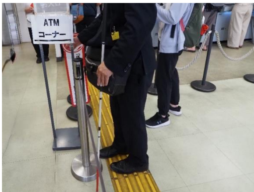
誘導用ブロック脇のポール
