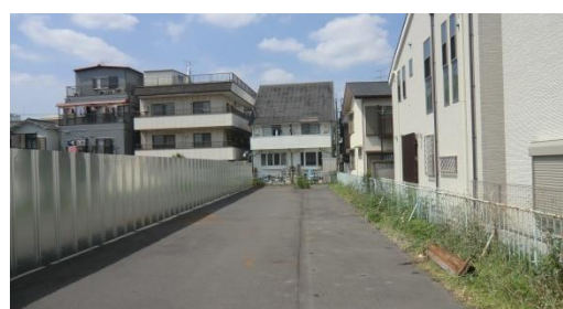
避難道路5号予定地
