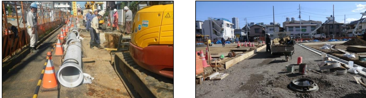
道路工事の様子
