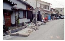
写真 ブロック塀の倒壊(阪神淡路大震災)
