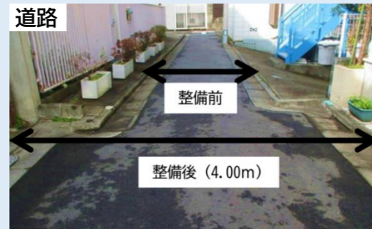
▲建物を後退して建替えることで狭い道路を解消 (中野区)
