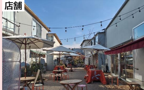
▲物販店舗や飲食店が立地してにぎわう 遊歩道(下北線路街)
