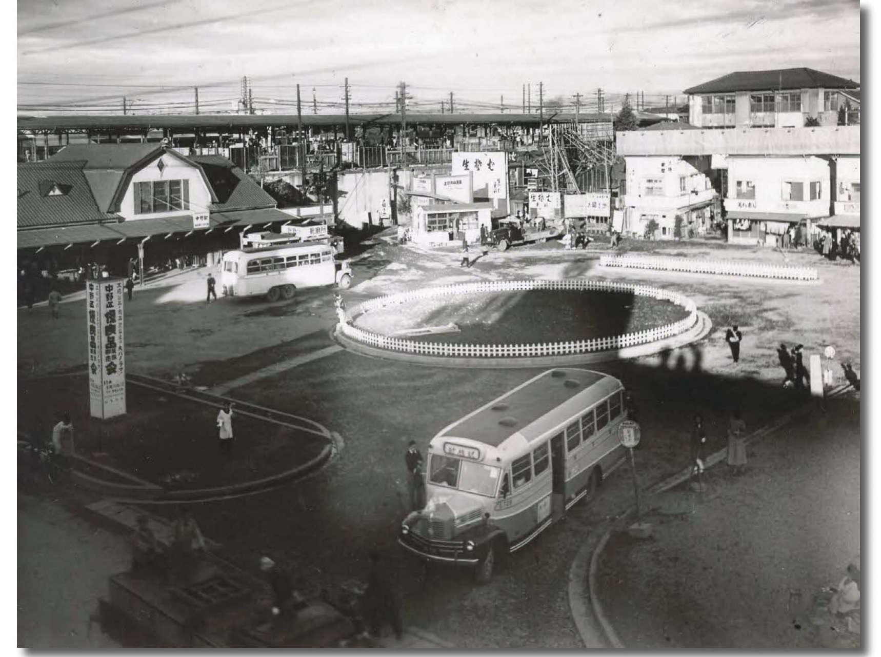
【昭和 26 年 中野駅南口広場工事完成(中野区提供)】
