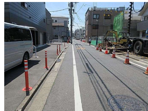
写真-2 工事、交通規制状況
