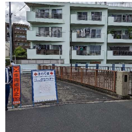
写真-1 通行止め、迂回実施状況
