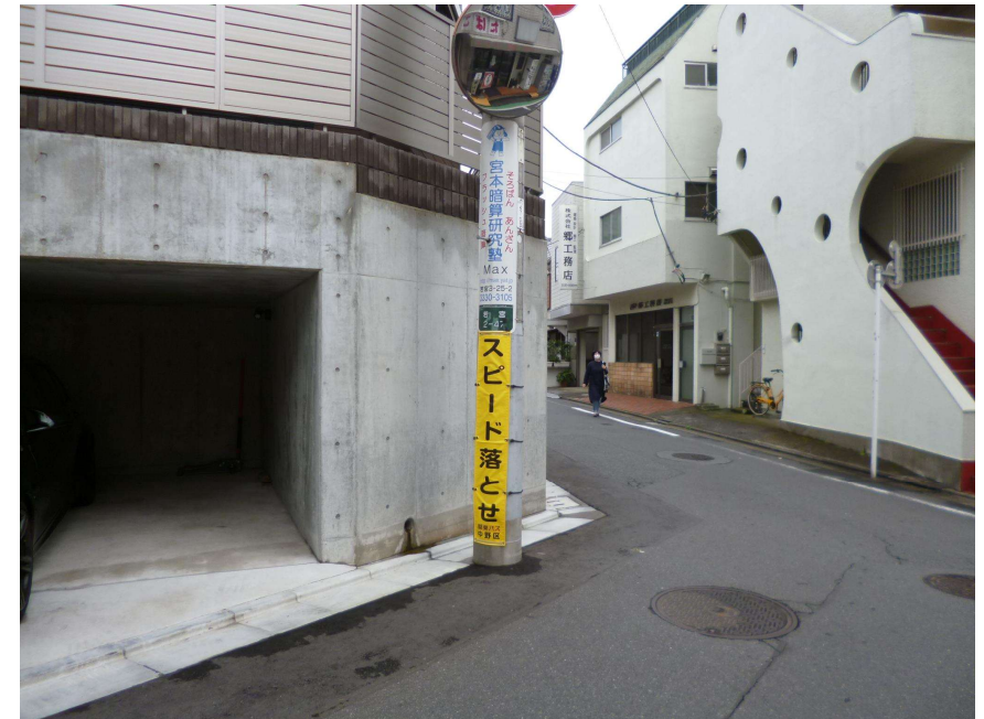
安全対策の一例（安全幕設置）
