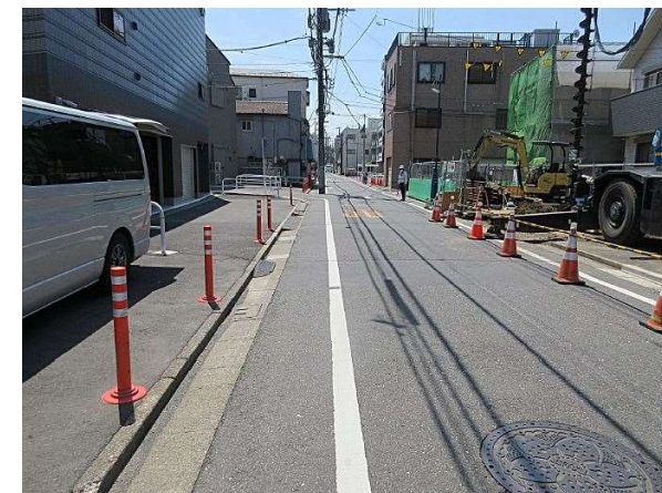
写真-2 工事、交通規制状況
