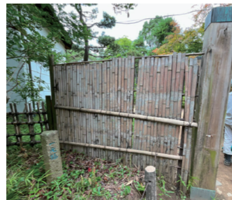
工事前の状態
