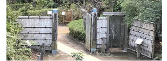
修復工事前の常識門の姿
