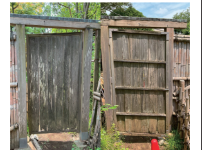
工事前の状態
