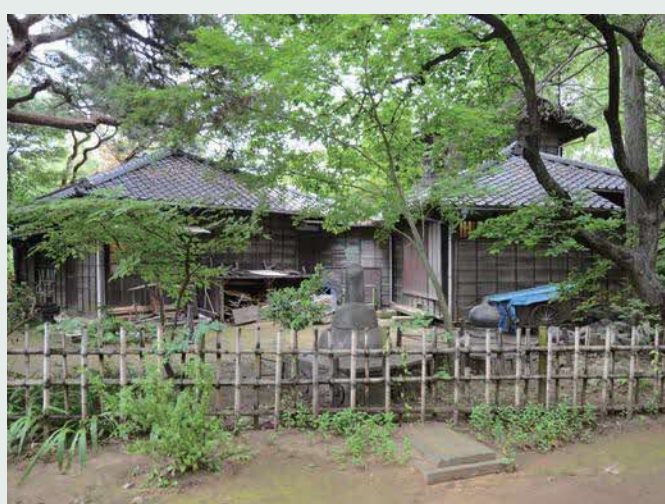
管理・作業用スペースとなっている裏庭 [現在]
