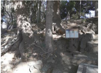
クスノキの根が「三字壇」に近接し、破損が広がる懸念がある
