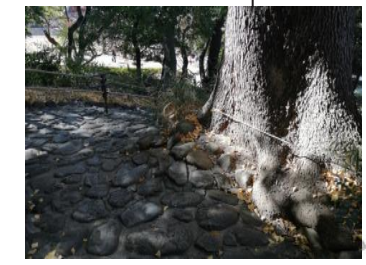
クスノキの根が成長し、階段を壊し始めている
