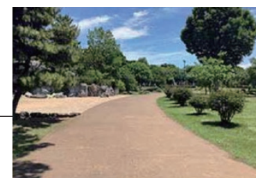
スラグ舗装への改修
