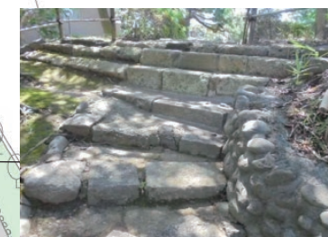
築山（梵天臺）の階段改修と切石の据え直し
