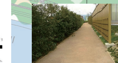
土系舗装の更新
