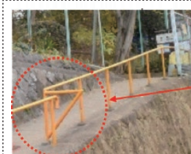
手すりの改修 (直線状に再配置)
