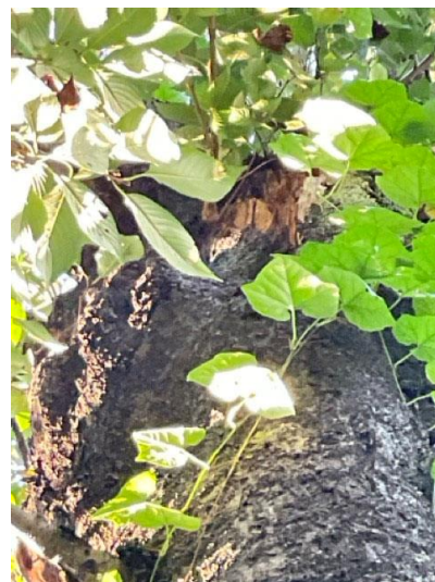
⑥大枝の樹皮欠損・腐朽
