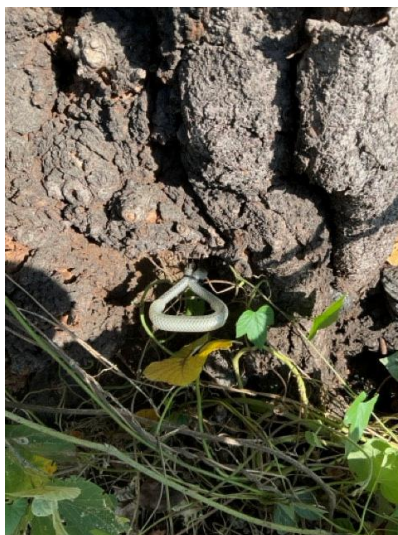
⑤鋼棒貫入異常
