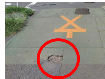
道路のアスファルトの表層が剥がれてしまう現象
