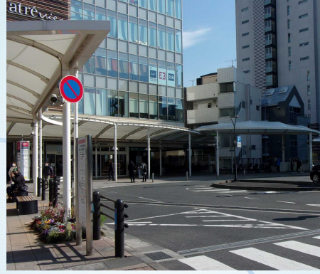
写真：東中野西口跨線橋 (東中野駅西口) ※平成27年竣工
