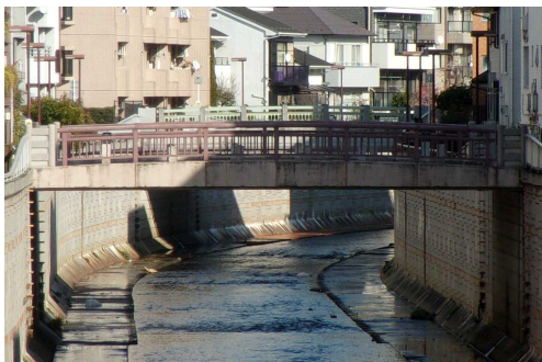
河川橋（河川を跨ぐ橋）
