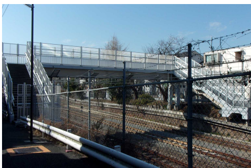
跨線橋（線路を跨ぐ橋）
