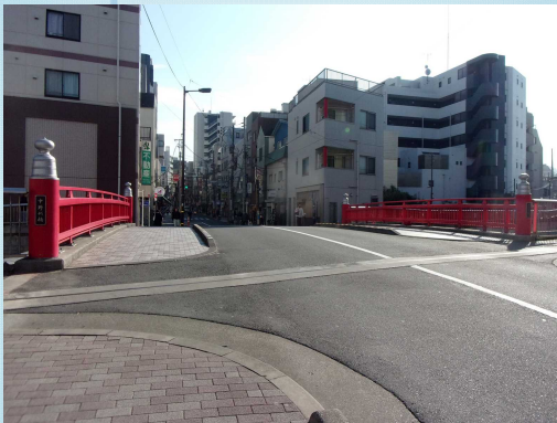
写真：中野新橋(神田川) ※平成23年竣工
