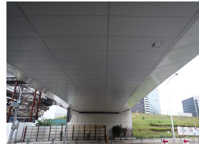
東西連絡路 桁カバー設置状況
