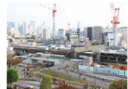
西側南北通路・橋上駅舎の整備が進む中野駅。周辺のエリアマネジメントビジョンを策定します
