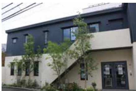
▲建物外観。1階が中野三丁目敬老館
