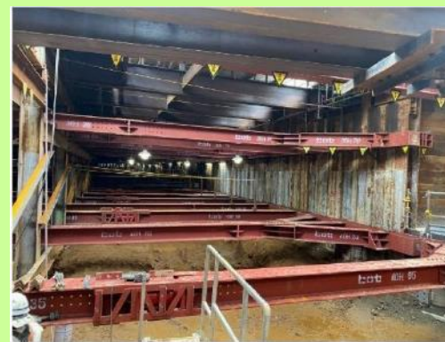
新宿区 土留支保工設置工事
