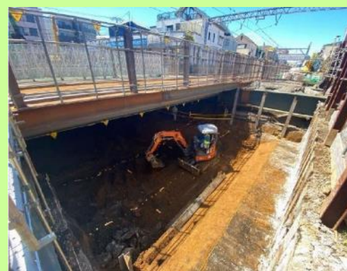
中井方取付部 掘削工事
