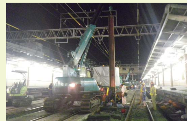
杭建込みの状況（写真-2）
