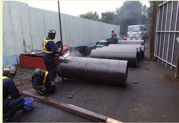
平和の森公園内の作業ヤード (写真-4)
