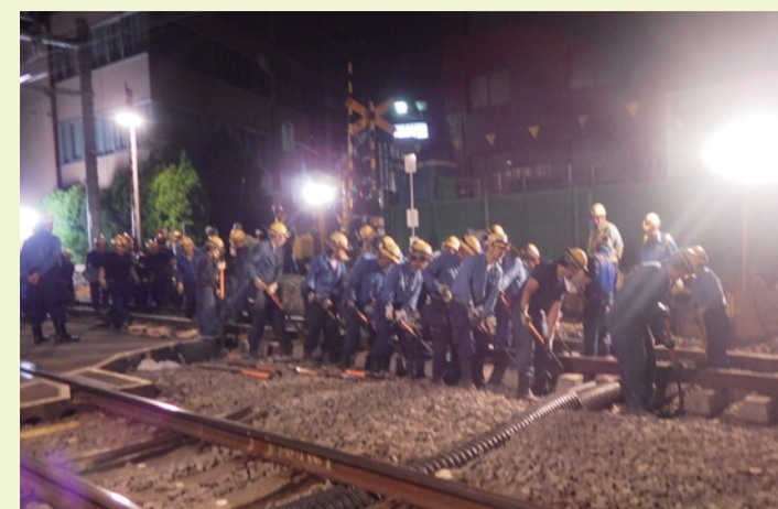
線路移設の状況（写真-1）
