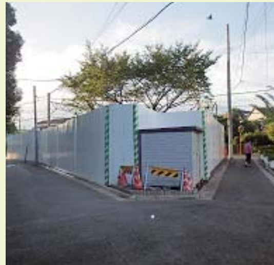
さんかく公園の一部を作業ヤードとして利用 (写真-5)
