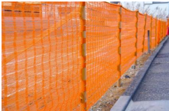
仮設名：仮囲い オレンジネット 万年堀撤去～フェンス工事が完了 するまで使用します
