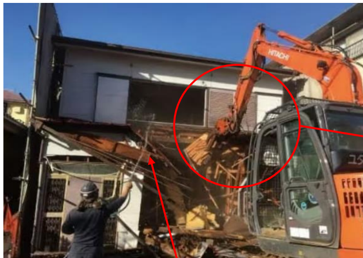
散水による粉塵飛散抑制
