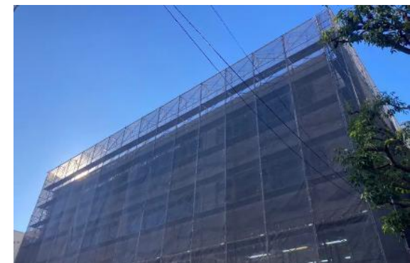
仮設名：外部足場 メッシュシートを張ります ※分室解体足場には防音パネルを 張ります
