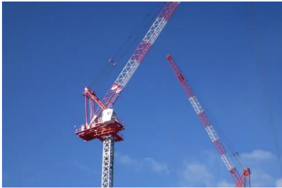
重機：タワークレーン
