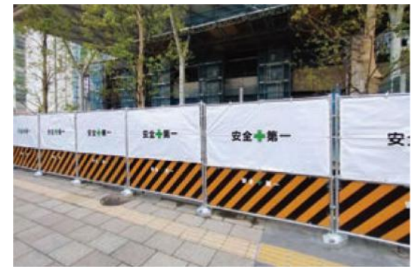
仮設名：仮囲い B型バリケード：H=1.8m 外構工事の時に使用します
