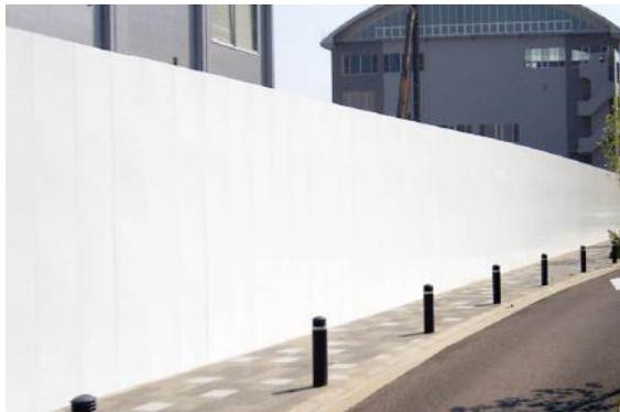
仮設名：仮囲い フラットパネル：H=3.0m 工程ごとに設置位置を変えながら 工事を進めます
