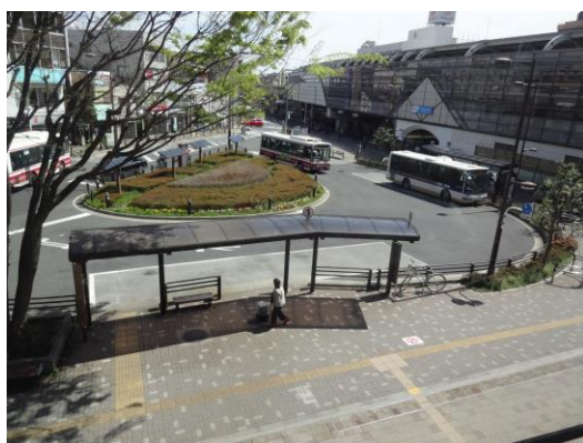
写真 創出する駅前の空間の例 (経堂駅北口)
