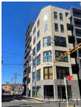
街並み誘導型地区計画に伴う道路斜線制限の緩和による建物
