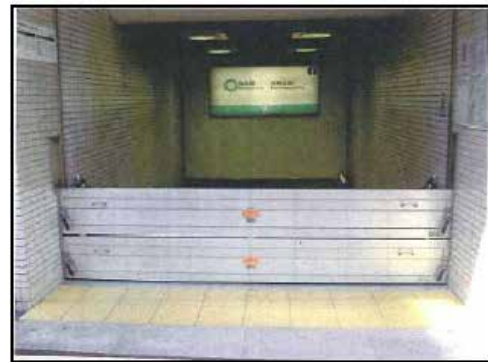
図 6-15. 止水板による地下浸水対策の例
