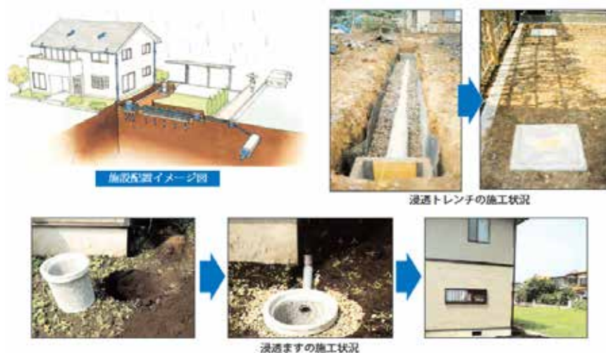
図 6-6. 浸透トレンチと浸透ますの施工
