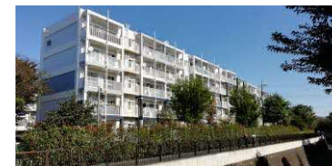
築60年以上経過した既存住棟
