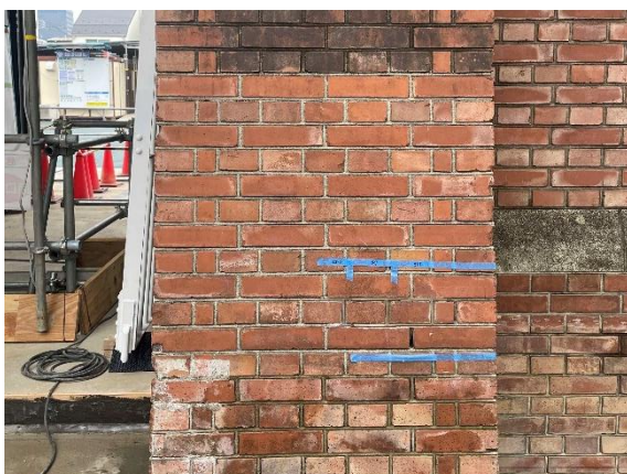
写真3 洗浄等を施した北面控え柱
