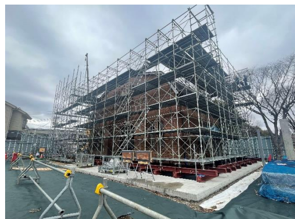
写真4 足場の設置状況
