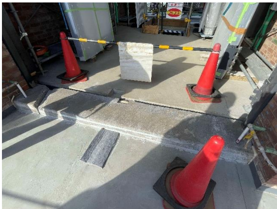
写真1 南面敷居石取付け状況
