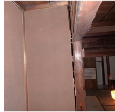
写真2 壁面の乖離
