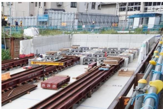
写真５ 免震装置基礎
