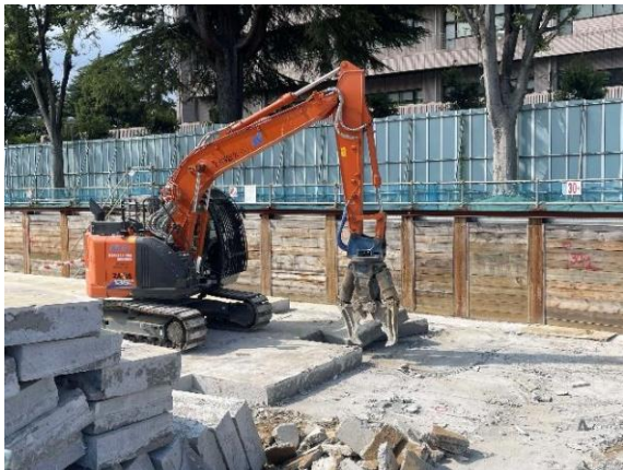
写真9 耐圧盤の撤去
