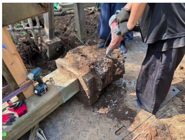
写真1 本柱抜き取り状況
