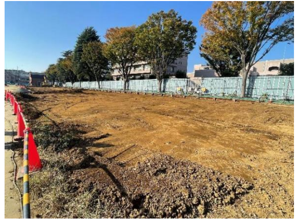
写真10 埋め戻し後の曳家経路
