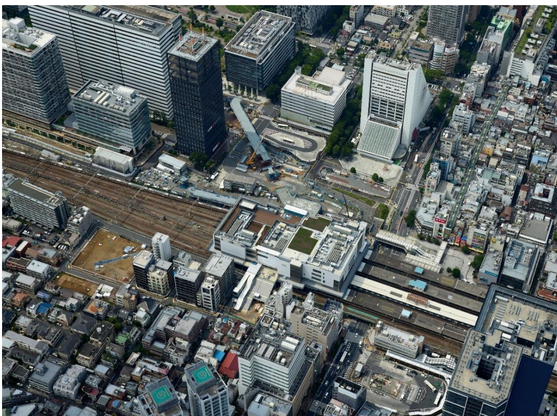
令和 8 年 6 月時点の工事進捗状況
