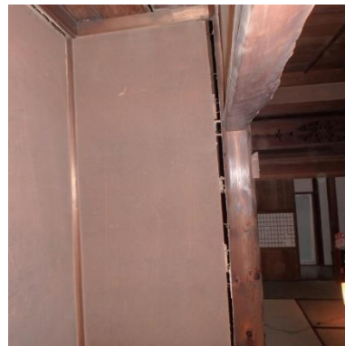
写真3 壁面の乖離
