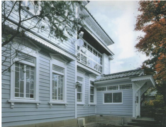
外観の状況（南西側から）
