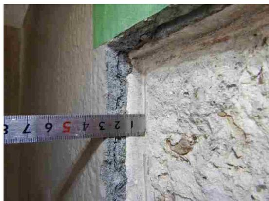
図 3-68 元守衛室東面 腰壁の断面
