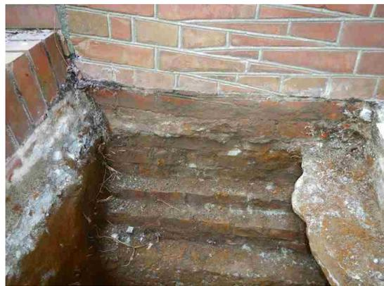
図 3-94 試掘① 通路東側 根積み部分
