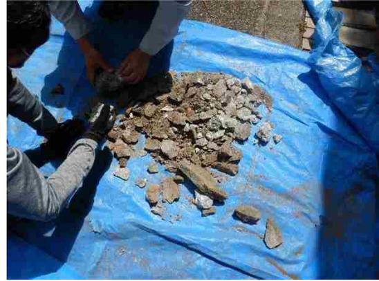
図 3-50 試掘① 舗装解体作業
