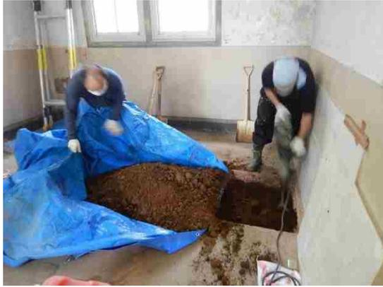
图 3-60 试掘② 復旧作業
