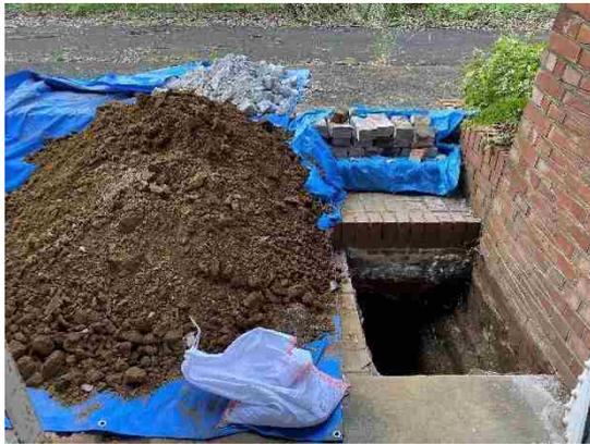
図 3-51 試掘① 掘削完了
