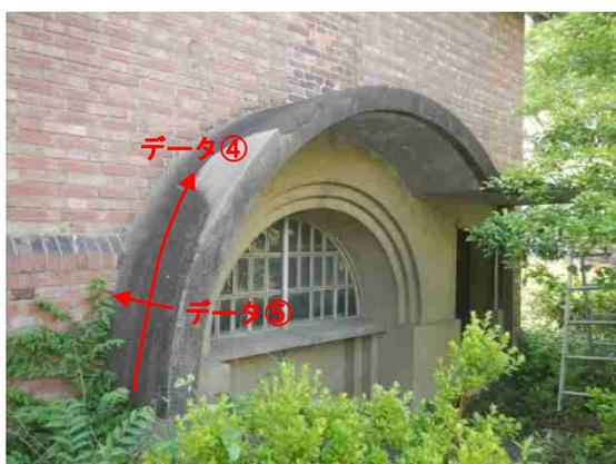
図 2-39 円形底上面鉄筋探査位置
