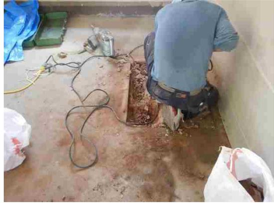
图 3-55 試掘② 床解体作業
