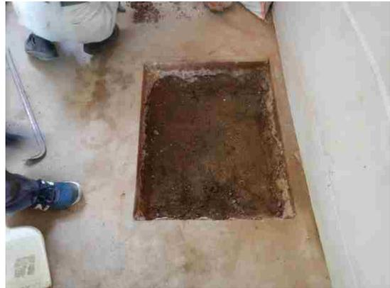
图 3-57 試掘② 床解体完了
