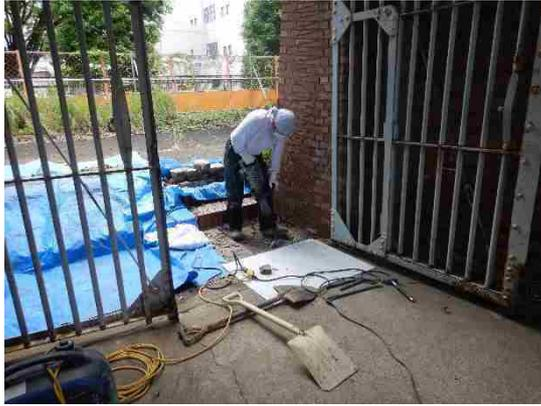
図 3-49 試掘① 舗装解体作業
