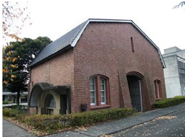
写真2 裏西側（北東側から）
