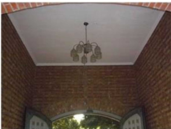
写真7 中央通路天井部分（北側から）
