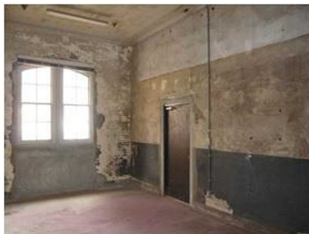
写真12 西側部屋内部（南側から）
