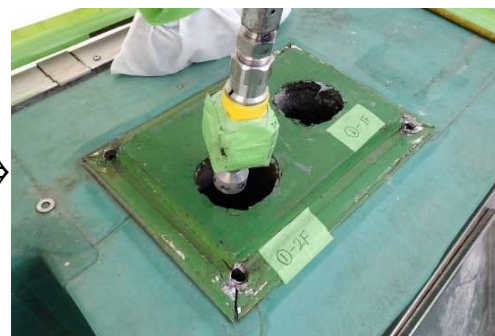
③ウォータージェット工法による除去作業
