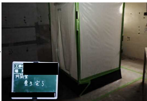
②飛散防止養生(下部)
