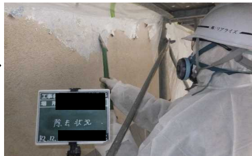
③手工具ケレン工法
