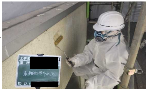
②剥離剤塗布
