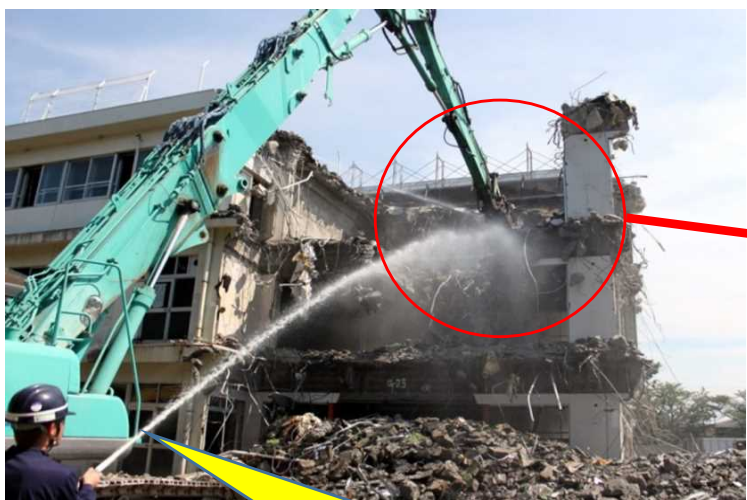
散水による粉塵飛散抑制
