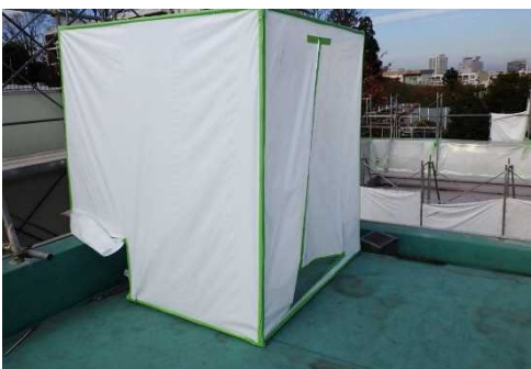
①飛散防止養生(上部)
