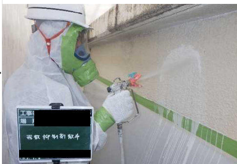
②飛散抑制剤散布
