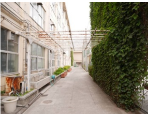
⑩校舎南側緑化フェンス
