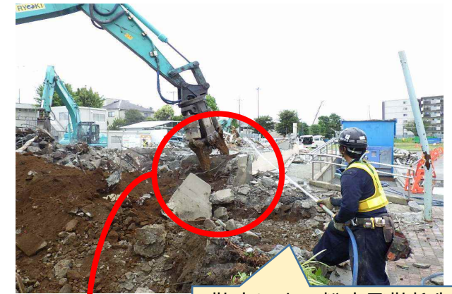
散水による粉塵飛散抑制
