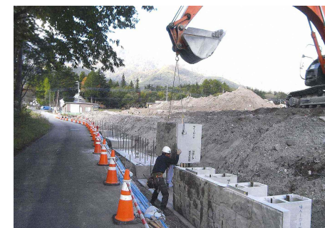
【擁壁設置工事】
