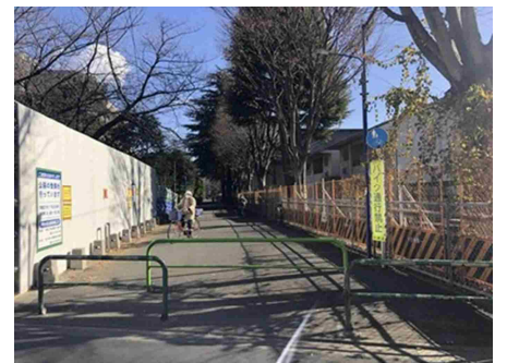
⑨北側下水道局管理通路
