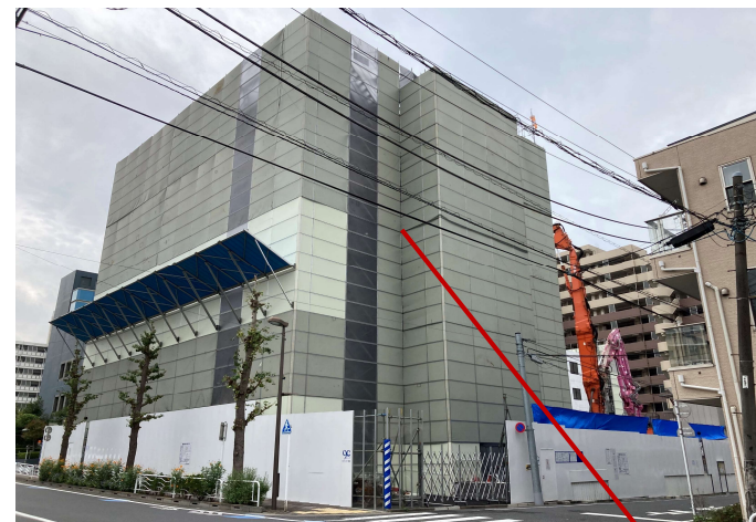
防音パネル （解体時）
