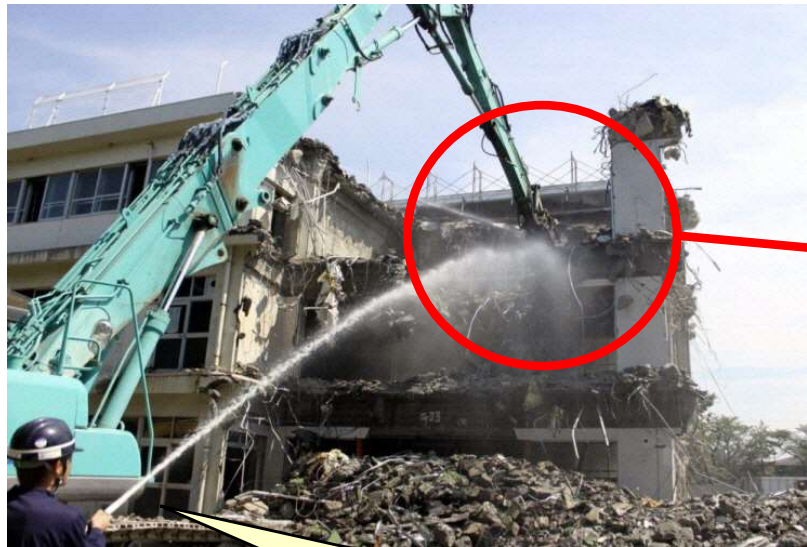
散水による粉塵飛散抑制
