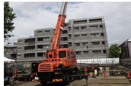
車両名:ラフテレーンクレーン車 資材を荷揚げする際に使用します。
