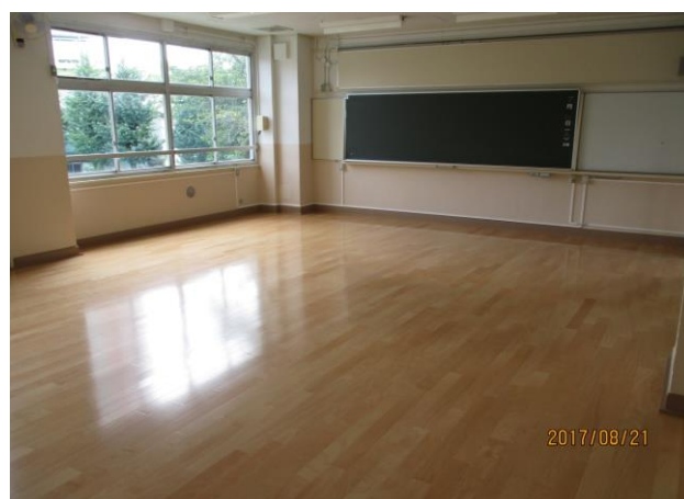
床・壁など、きれいに改修された普通教室
