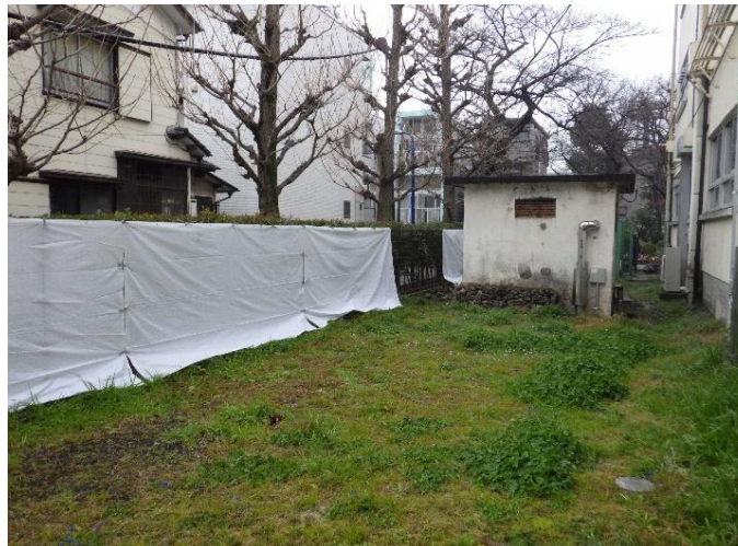
防災シート設置状況
