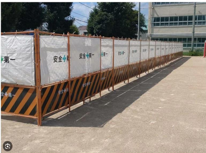
バリケード設置状況
