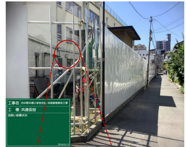
透明パネル設置状況
