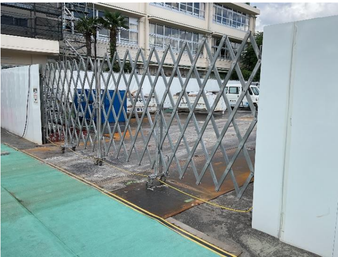
出入口ゲート設置状況
