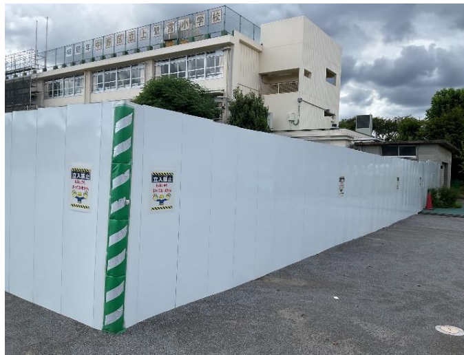
仮囲い設置状況
