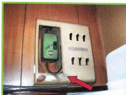
ブレーカー下部から出入していたためカバーが真っ黒
