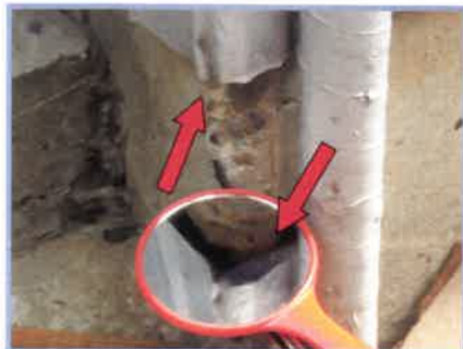
角に特に隙間がしやすい (鏡の中に隙間が見えます)
