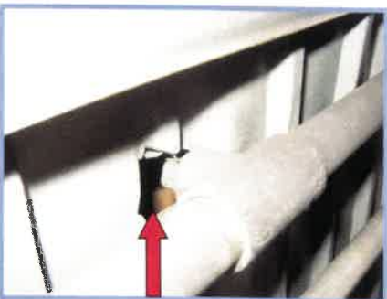
水道管の壁貫通部分
