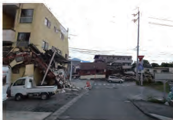
建物は崩れ、道路には亀裂が入っている。 熊本地震(平成28年)
